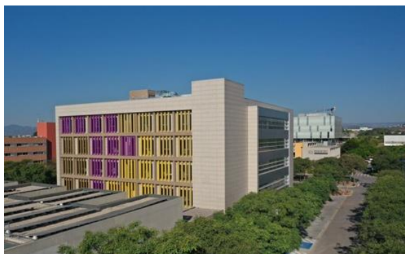
Figure 7. INAM's premises are being allocated in Edifici d'Investigació II.
